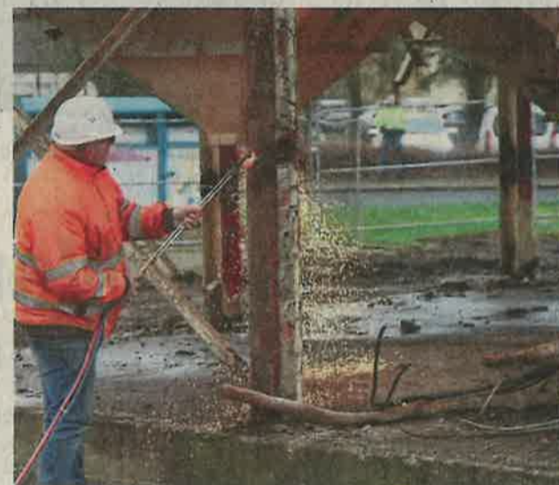
Die Fachleute von der Firma Hohoff aus Lippborg durchtrennten die Stahlträger mit Schweißbrennern. FOTO: DAHM
